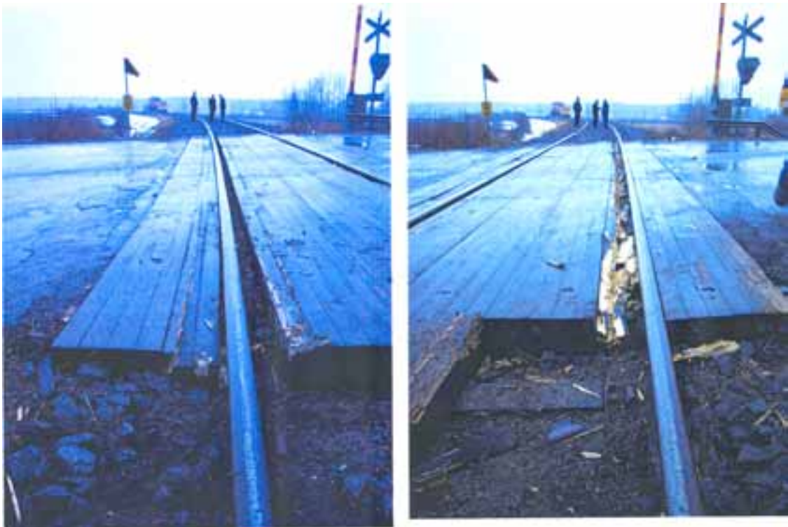
Kuva 2. Tavarajunan veturin pyöräkerran suistuminen kiskoilta Koskenkorvan liikennepaikalla 30.3.2003. Kuva vaurioituneesta tasoylikäytävästä. Taustalla suistunut veturi.
